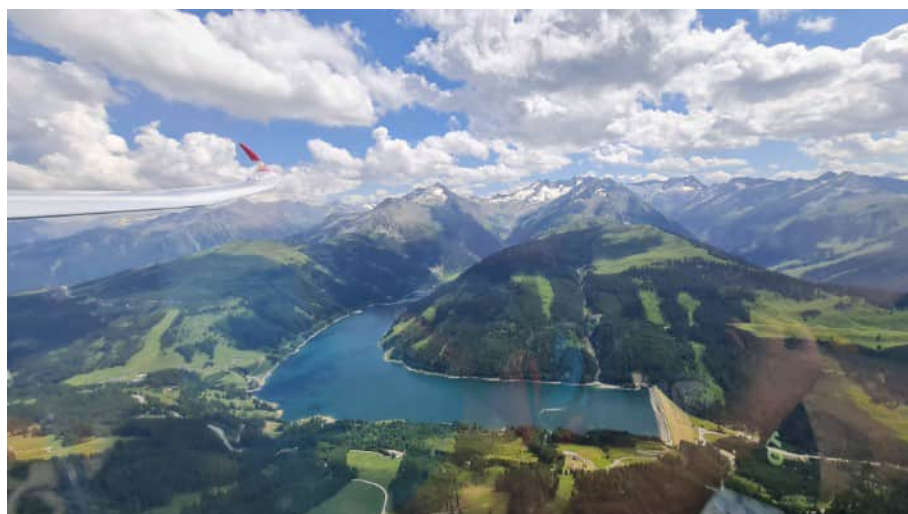
Speicher Durlaßboden mit Blick auf die Venedigergruppe
