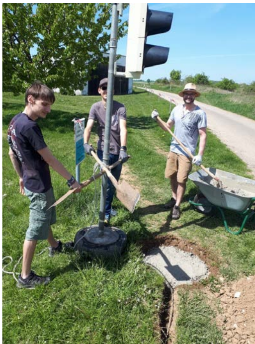
Bautrupps beim Einbetonieren
